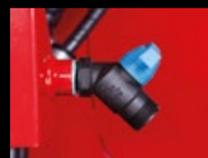
**Torneira d'água** autoalimentada pela condensação do ar-condicionado.
